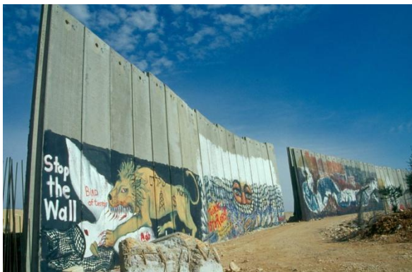
Stahlbetonmauer in Bethlehem
